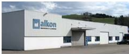
Alkon mit Sitz in Wutöschingen-Degernau hat sich auf die Herstellung kleiner und mittelgroßer Teile bis 1.500 Millimeter Länge spezialisiert.
